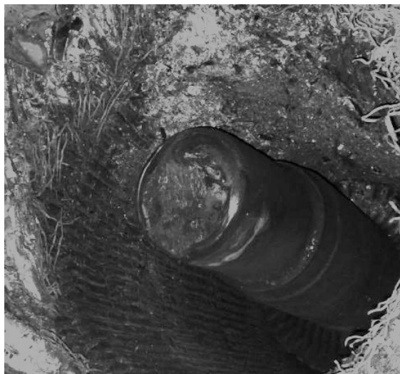
Abbildung 1-1: Abgerissene Welle eines Turbogenerators
