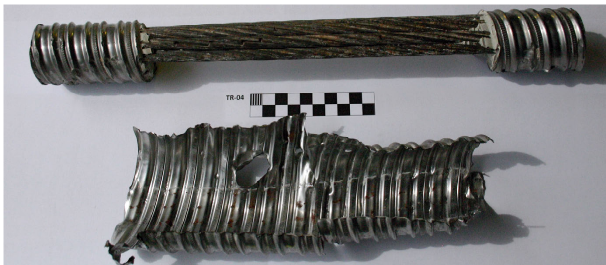
Bild A 3-32: TR04 – Entnommene Spannlitzen und Hüllwellrohr
