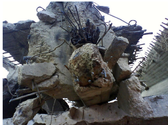
Bild 5-2: Spannbetonträger mit Kastenspannglied
