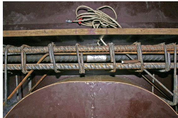
Bild 5-48: Druckbewehrung Versuchsträger mit „altem“ Spannstahl
