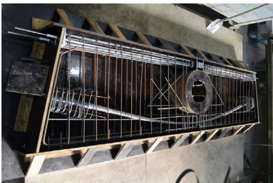
Bild 5-51: Bewehrung und Spannglied
