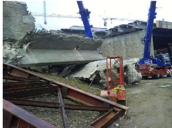
Bild 5-1: Brückenabbrucharbeiten der Autobahnbrücke Bahnhof Westhofen
