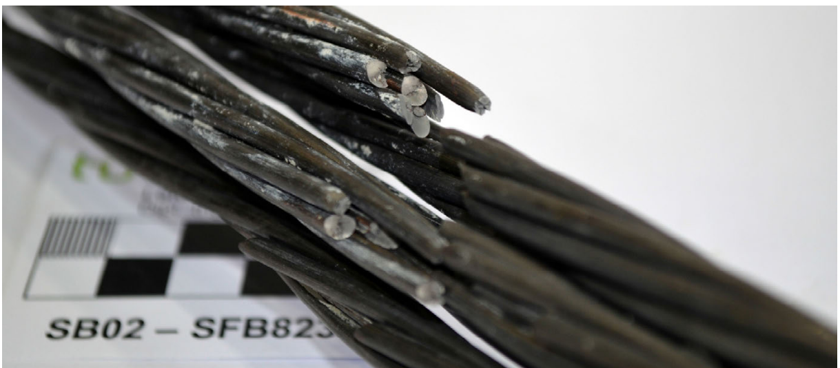
Bild A 3-52: SB02 – Detailaufnahme der Drahtbrüche
