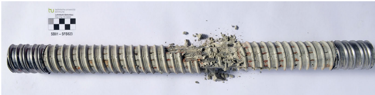
Bild 5-91: Entnommenes Spannglied, Aufsicht, hier: SB01
