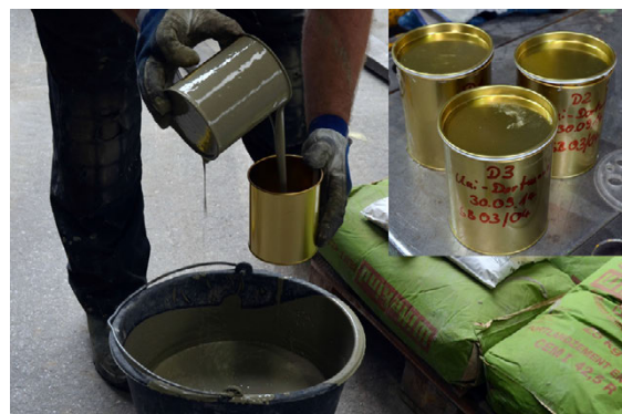
Bild 5-55: Probennahme vom Verpressmörtel
