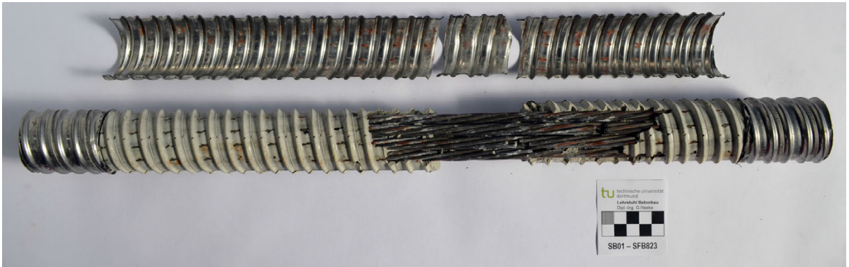
Bild A 3-44: SB01 – Entnommene Spannlitzen und Hüllwellrohr
