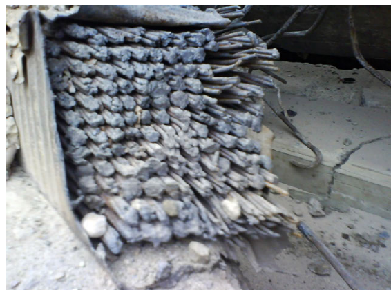
Bild 5-3: Spannlitzen im Kastenspannglied nach Abbruch
