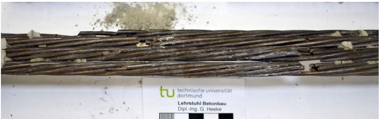
Bild A 3-57: SB03 – Spannstahl mit Drahtbrüchen
