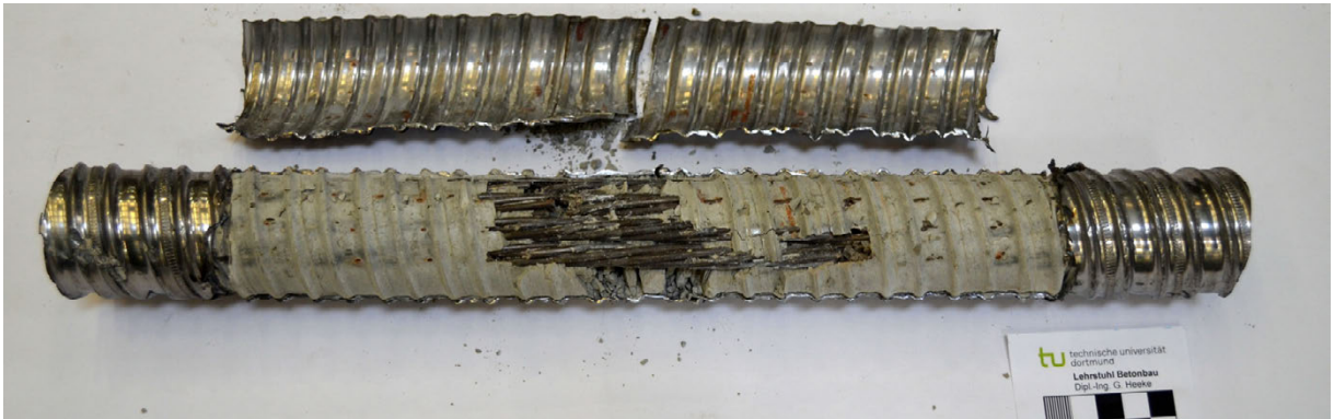
Bild A 3-56: SB03 – Entnommene Spannritzen und Hüllwellrohr
