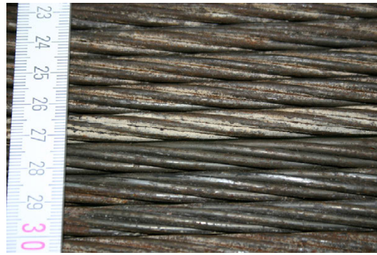
Bild 5-5: „alte“ Spannlitzen nach der Anlieferung
