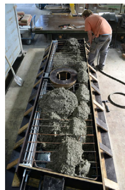
Bild 5-52: Herstellung des Balkens
