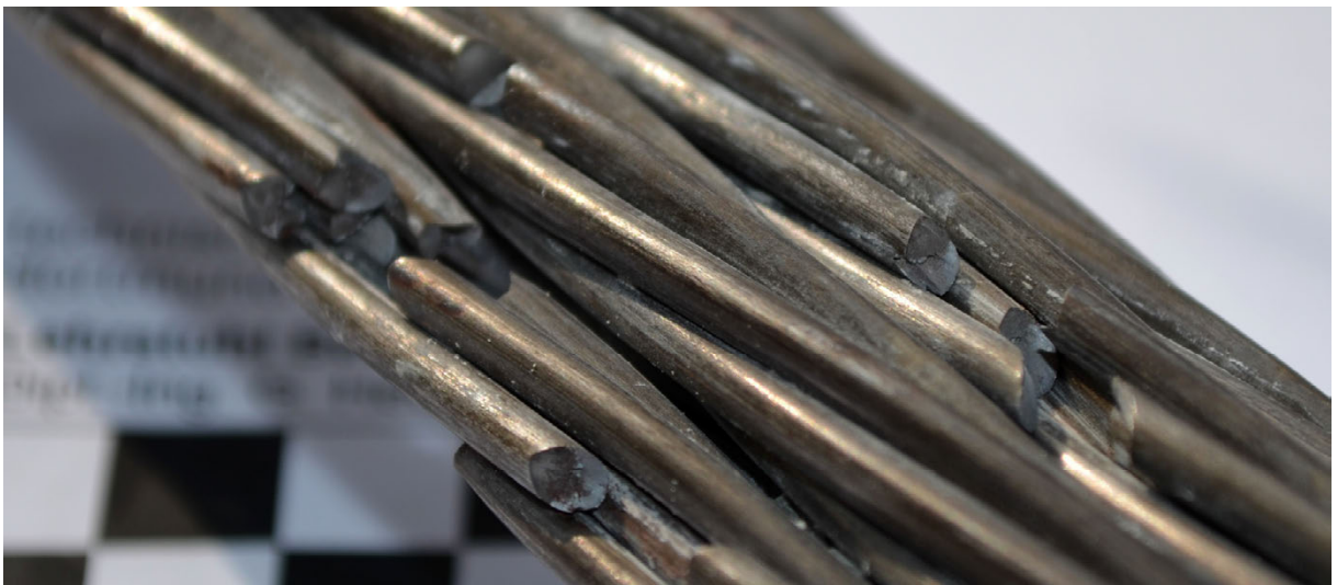
Bild A 3-64: SB04 – Detailaufnahme der Drahtbrüche
