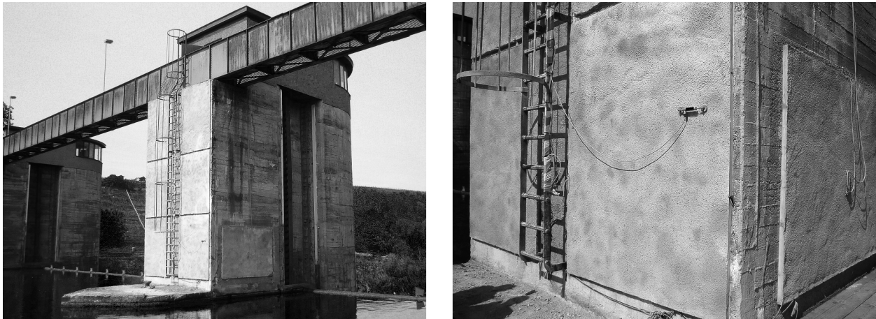
Bild 7–21: Durchgeführte Probeinstandsetzung nach dem ersten Winter
