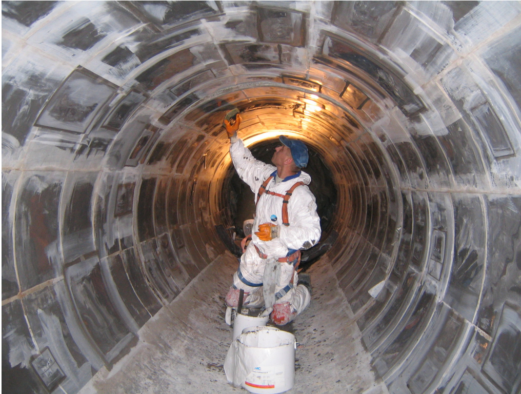
Bild 7-9: Abwasserrohr mit Boro-Silikat-Dünnglas instandgesetzt
