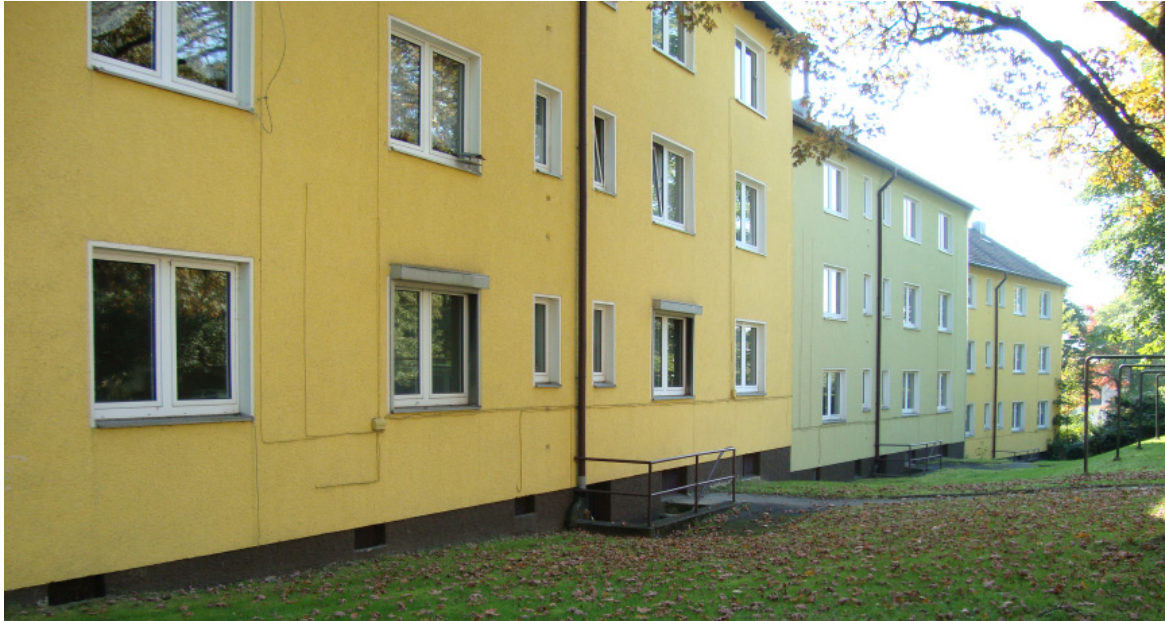
Abbildung 140: Modernisierungsbedarf bei der Gebäudesubstanz (Quelle: Eigene Aufnahme)
