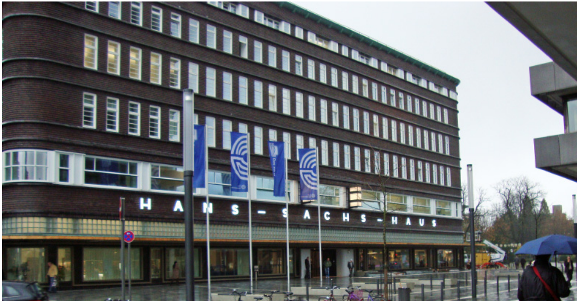
Abbildung 112: Leuchtturmprojekt Umbau Hans-Sachs-Haus (Quelle: Eigene Aufnahme)
