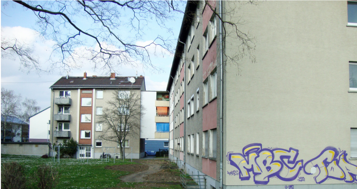
Abbildung 144: Zustand der Gebäude in Kostheim und Kastel (Quelle: Eigene Aufnahme)
