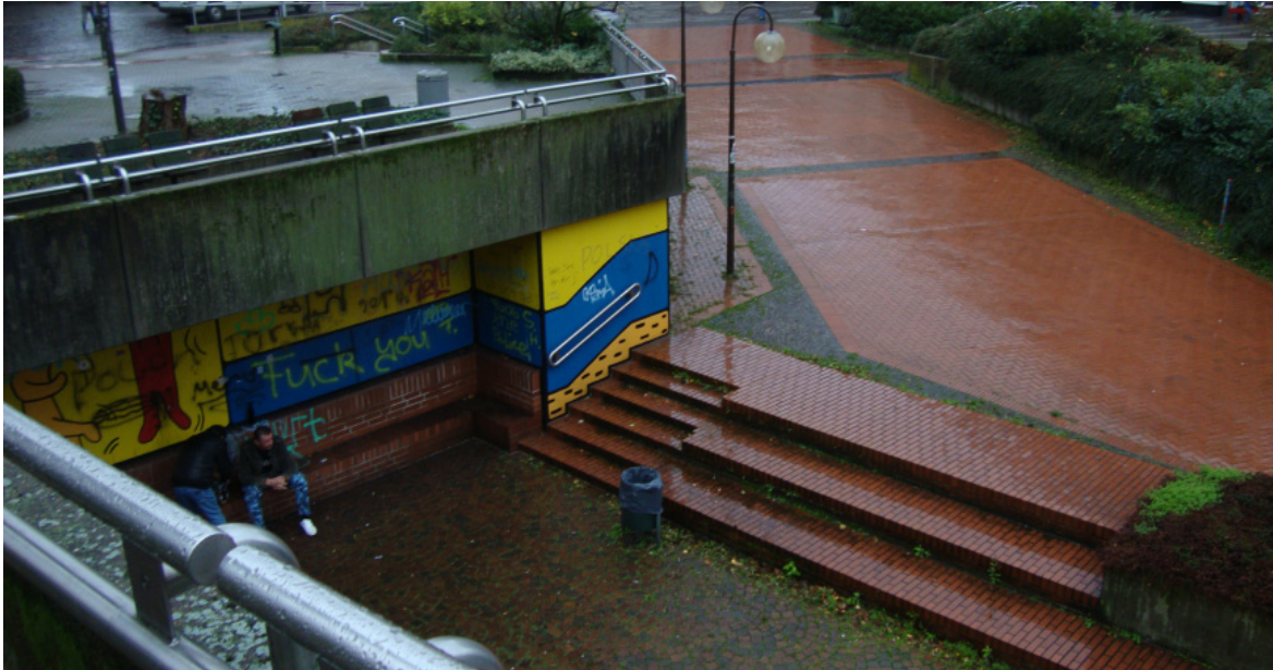
Abbildung 108: Umbau des Heinrich-König-Platzes (Quelle: Eigene Aufnahme)
