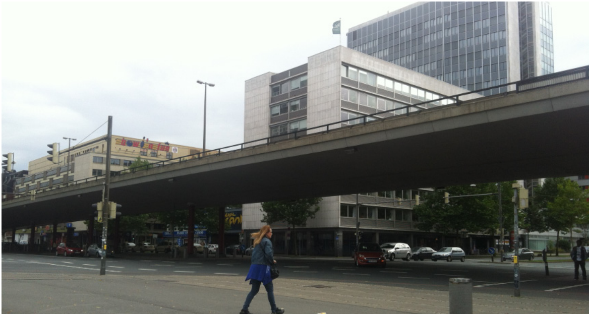
Abbildung 26: Dominanz durch Hochstraße am Bremer Hauptbahnhof (Quelle: Eigene Aufnahme)
