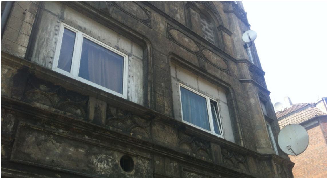
Abbildung 33: Mangelndes Bewusstsein für gestalterische Details bei vielen Privaten (Quelle: Eigene Aufnahme)
