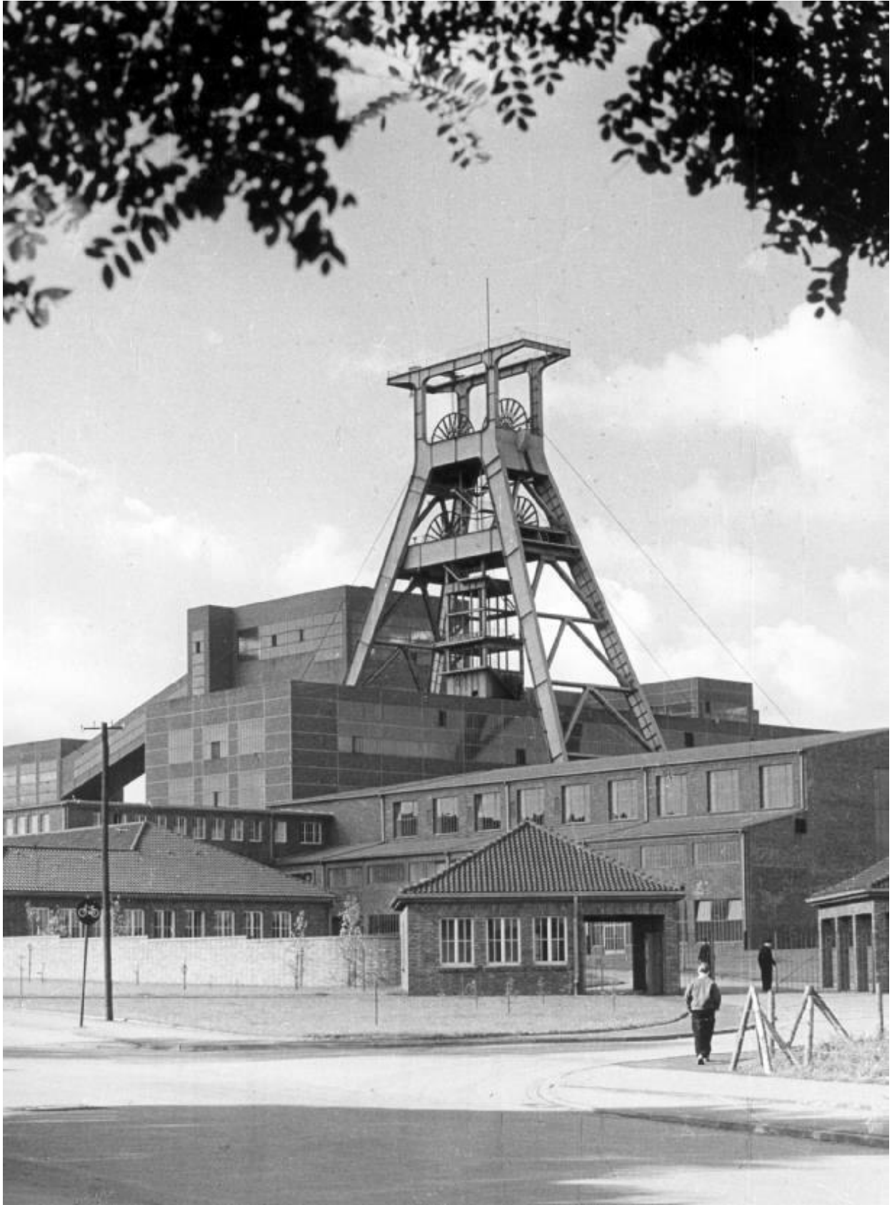
Abb. 39: Zentralschachanlage Germania, Tagesansicht BBA, Bestand 5, Lfd.Nr. 387/1
