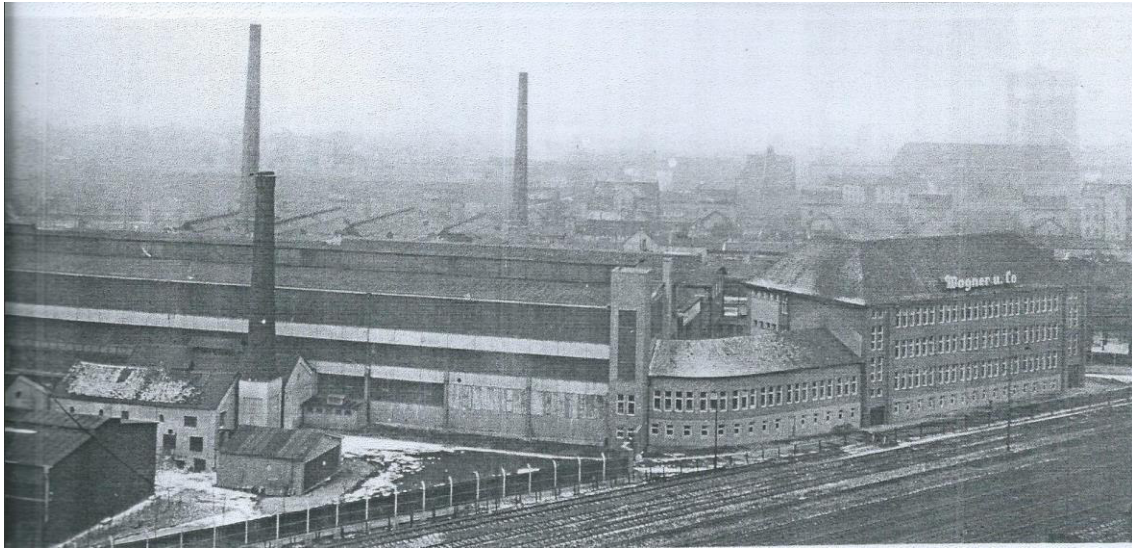
Abb. 51: Maschinenfabrik Wagner, Montagehalle und Bürogebäude
