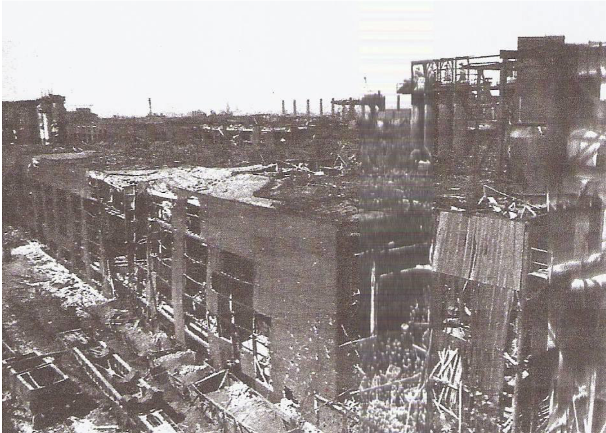
Abb. 77: Hydrierwerk Scholven I / II, zerstört
