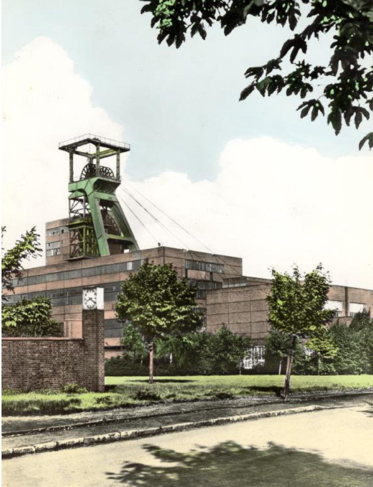
Abb. 28: Schacht Gustav I/II, Förderturm und Schachthalle
