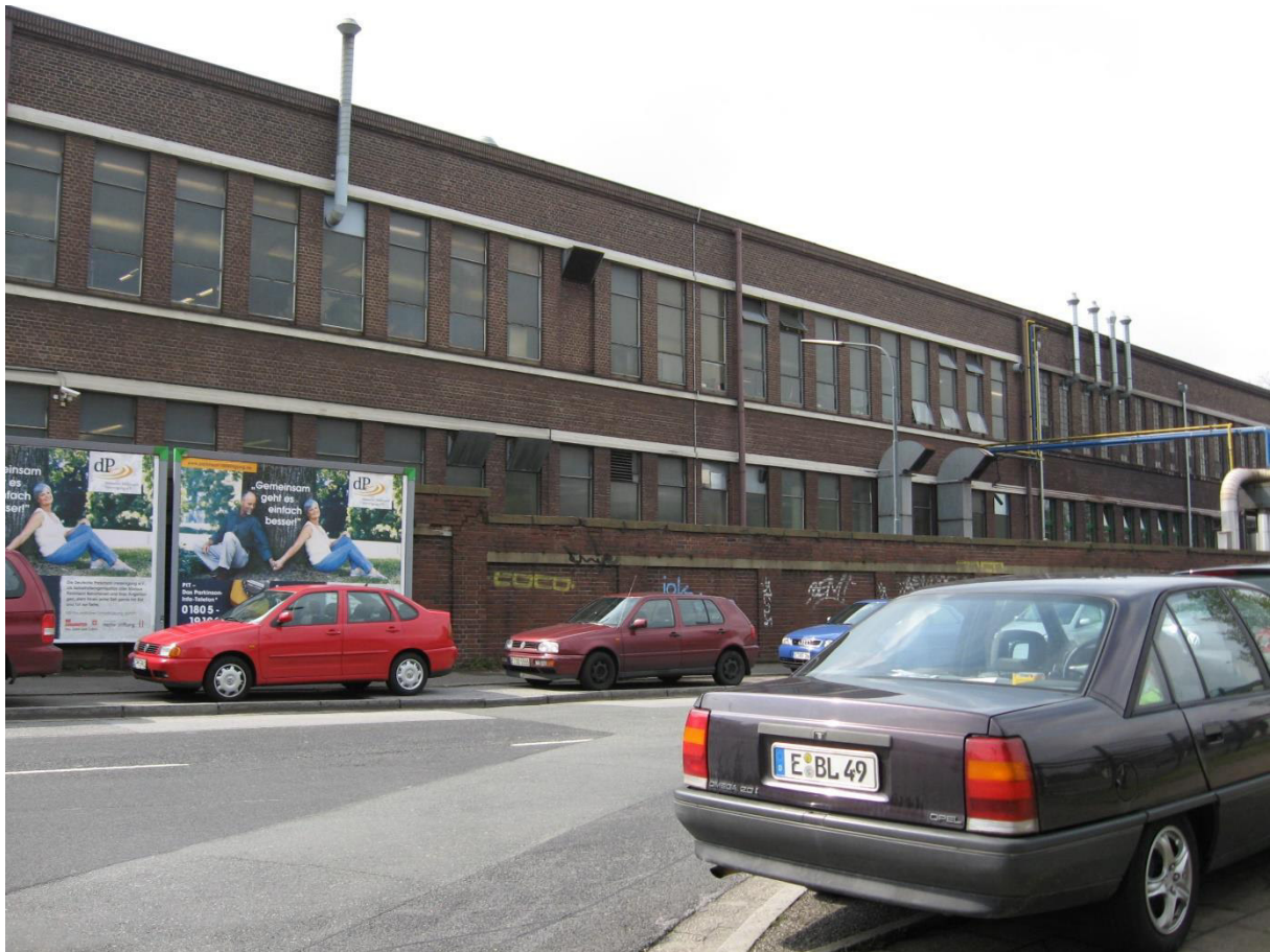
Abb. 60: WIDIA – Fabrik, Erweiterungsbau
