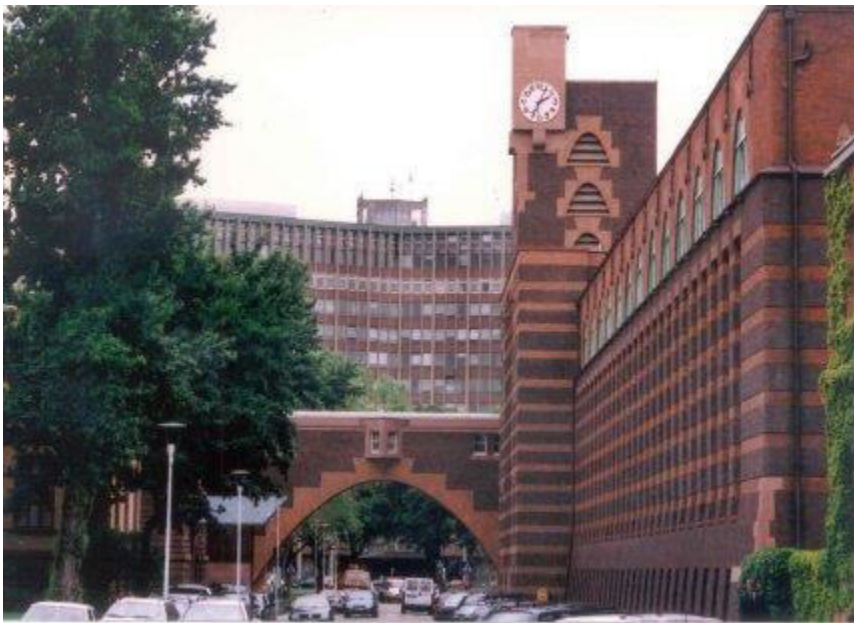
Abb. 50: Verwaltungsgebäude Hoechst, Peter Behrens, Frankfurt
