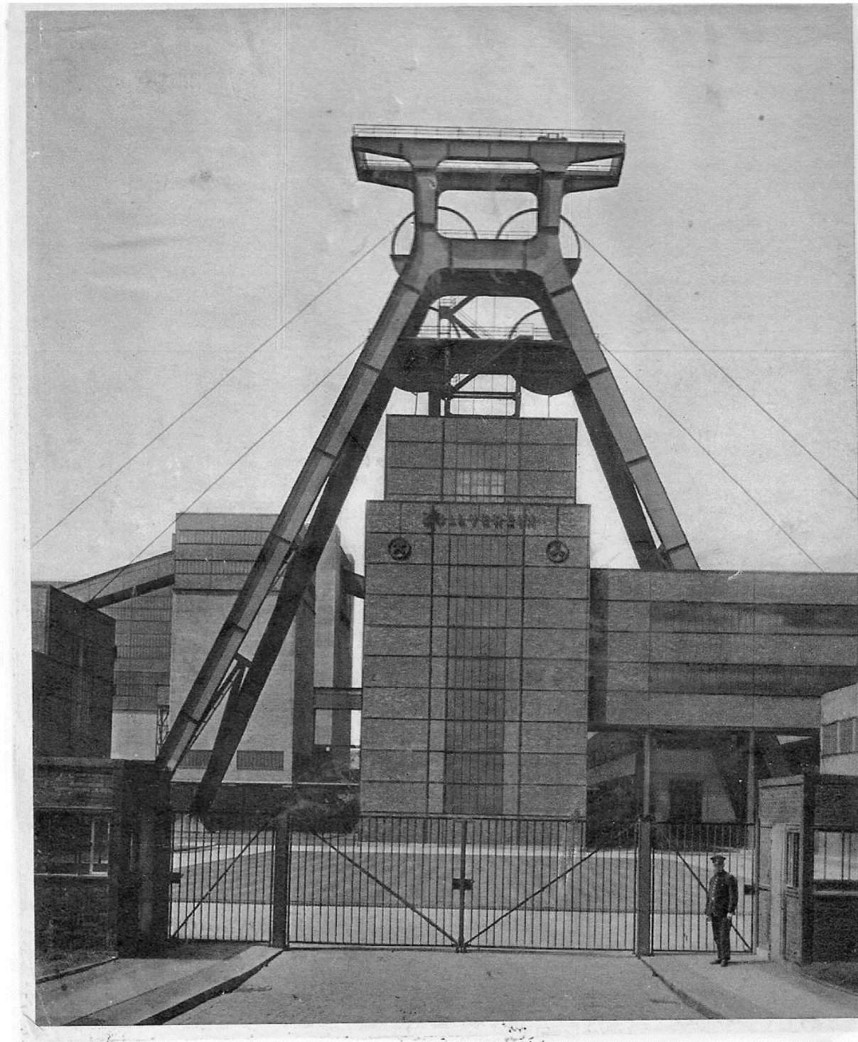
Abb. 38: Zeche Zollverein, Zentralschacht XII
