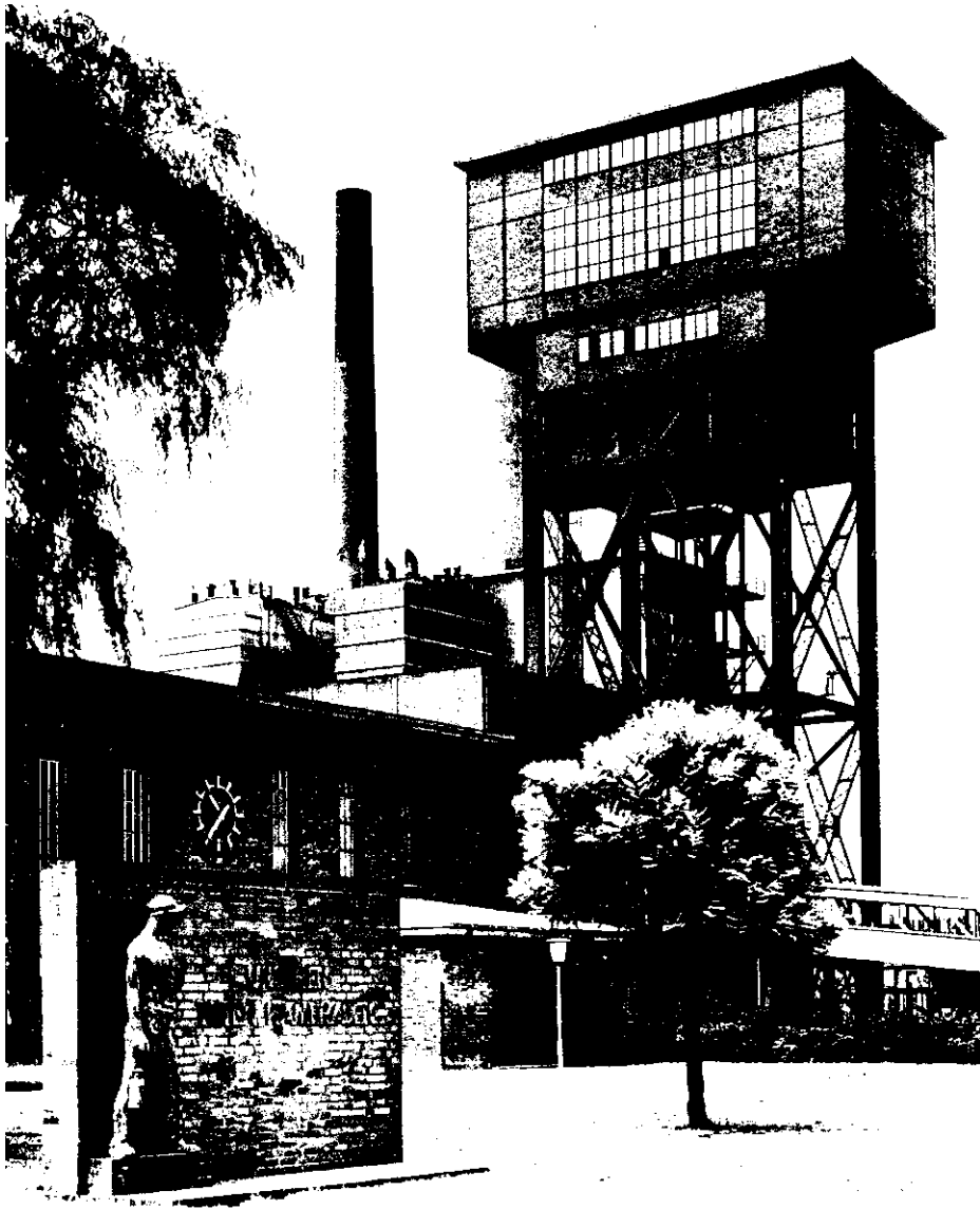
Abb. 11: Minister Stein, Schacht II, Hammerkopfturm
