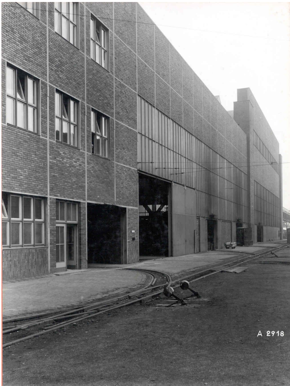
Abb. 43: Bochumer Verein, Stahlwerk I , dahinter Stahlwerk II
