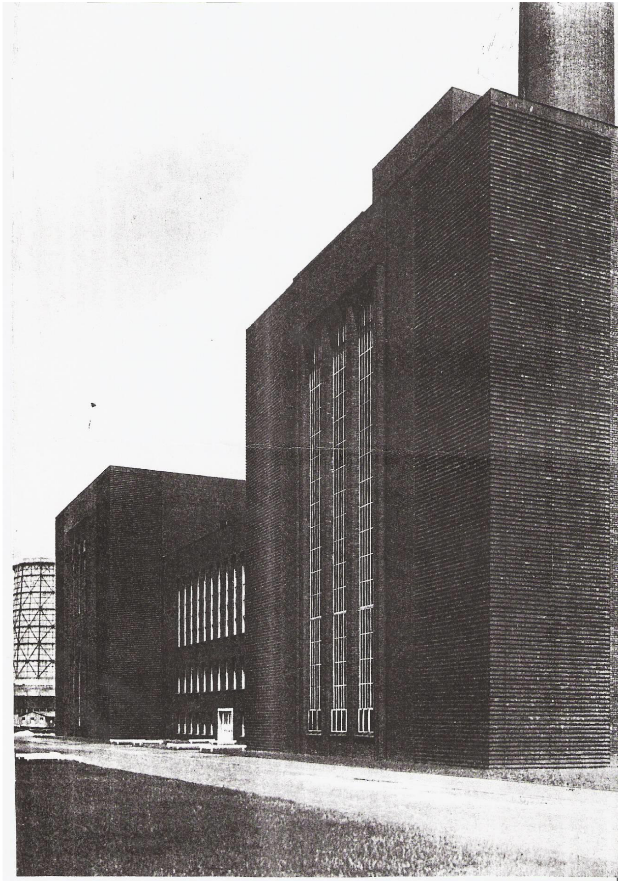
Abb. 81: Kesselhaus Gelsenberg Benzol AG
