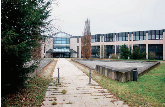
Zuvor vom DuPont-Konzern genutztes leer stehendes Gebäude im Gewerbepark Südcampus in Bad Homburg Foto: Hendrik Jansen
