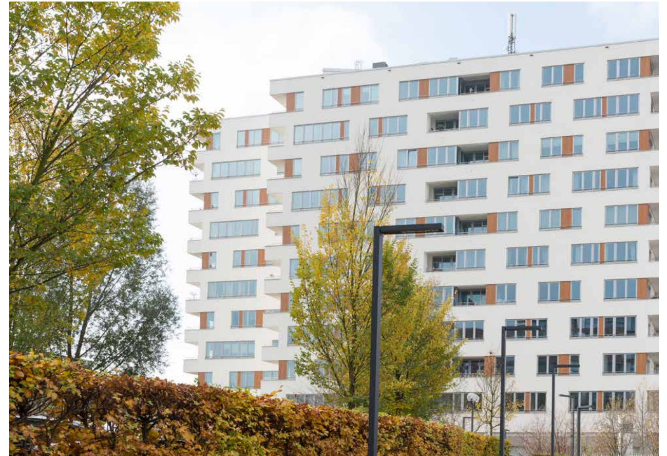
Abb. 30: Die Neugestaltung der Fassade lässt das Gebäude als Neubau erscheinen. Quelle: Magdalena Gruber
