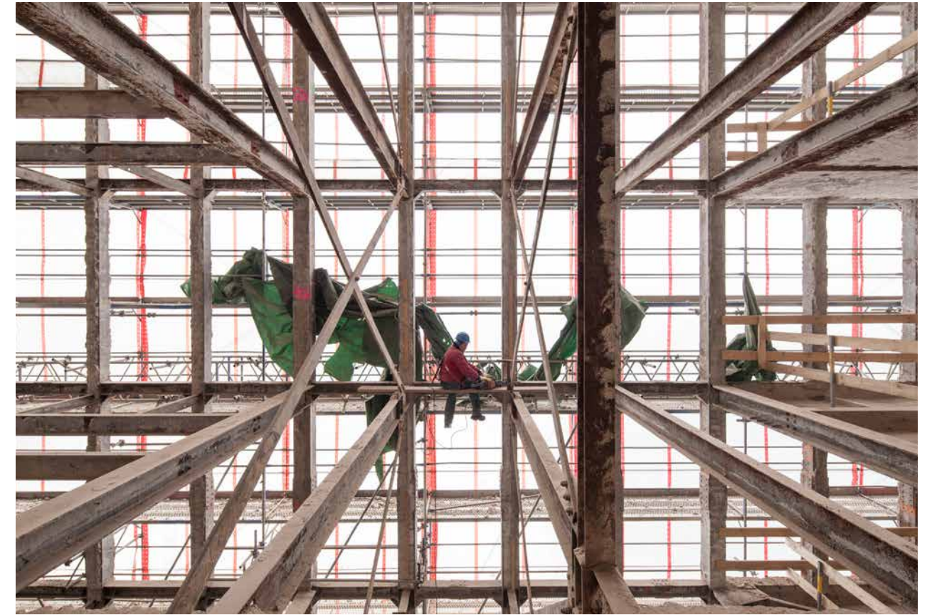
Abb. 40: Die tragende Konstruktion wurde weitestgehend freigelegt. Quelle: Markus Schwier
