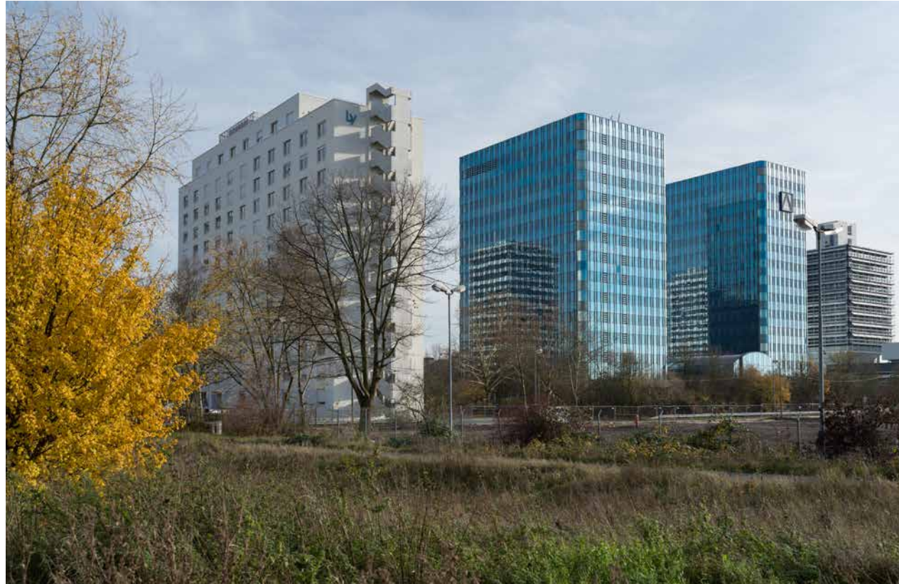
Abb. 19: Im ehemaligen Büropark Niederrad, sind die ersten Umbauten von Büro- zu Wohngebäuden bereits fertiggestellt. Quelle: Magdalena Gruber
