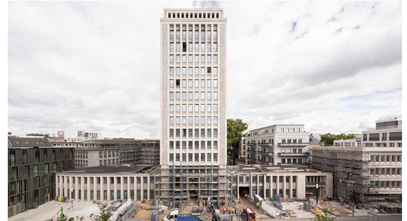
Abb. 38: Das Gerling-Hochhaus in der Umbauphase. Quelle: kister scheithauer gross
