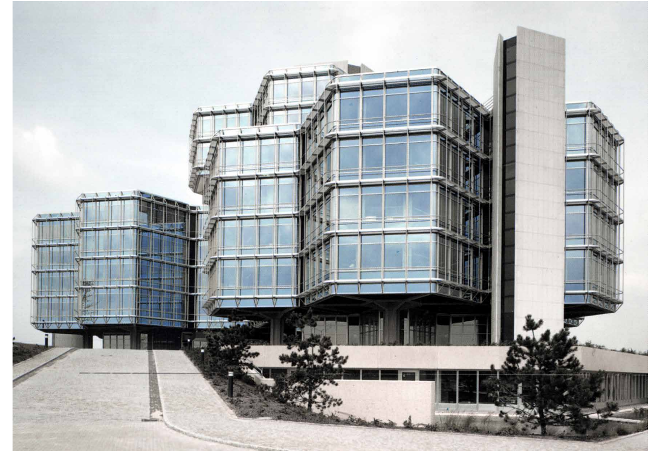
Abb. 16: ehem. Magdeburger Versicherung, 1978, Hannover, Ansicht mit erkennbarer Wabenstruktur. Quelle: Bahlo, Köhnke, & Partner
