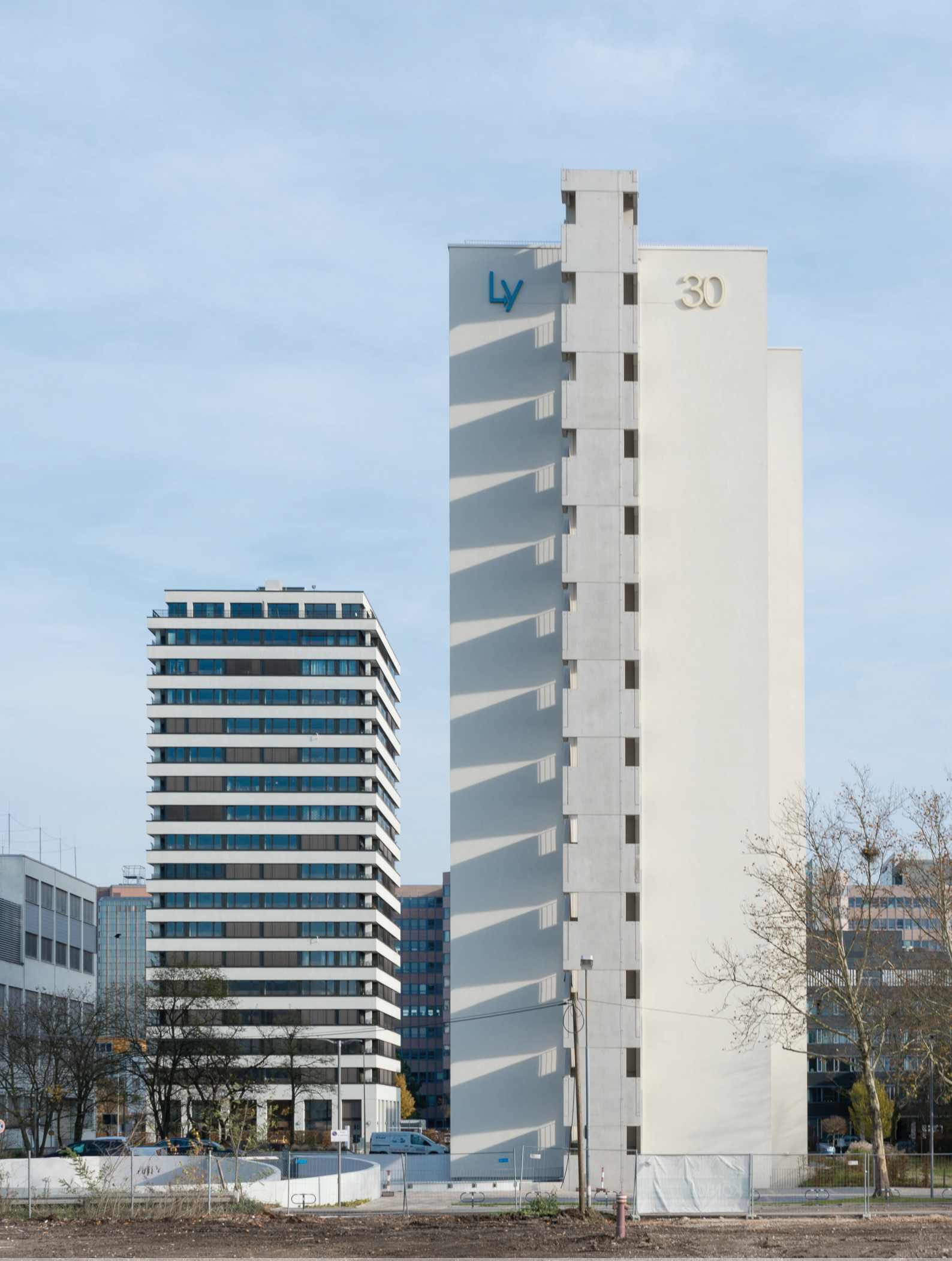
Abb. 26: Die Gebäude Lyoner 19 (li.) und Ly 30 (re.) wurden im Frankfurter Lyoner Quartier von leerstehenden Bürogebäuden zu Wohnungen und Mikroapartments umgebaut | Quelle: Madgalena Gruber
