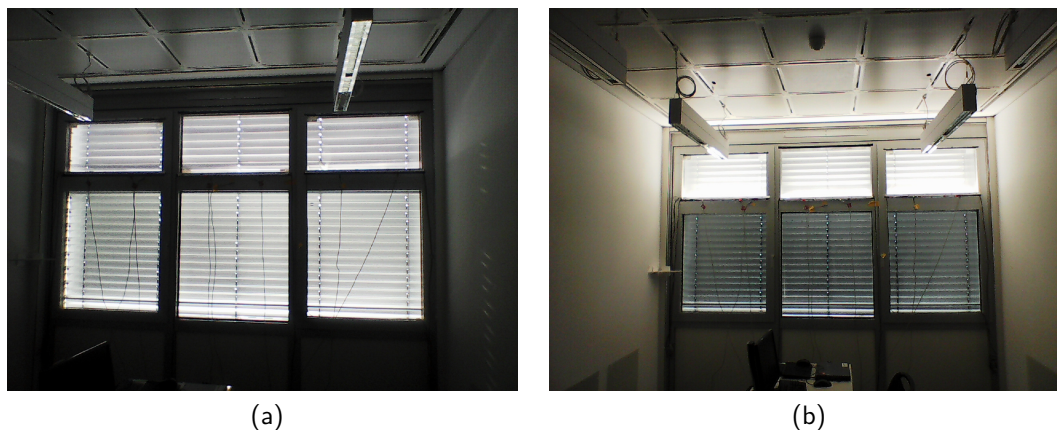
Abb. 5.28: Scheibenverbund mit von Jungbecker heißgeprägten, industriell gefertigten Flächenstrahlern, eingebaut im oberen Bereich einer Fassade am FhG-IBP. (a) LEDs sind ausgeschaltet, (b) LEDs sind eingeschaltet.
