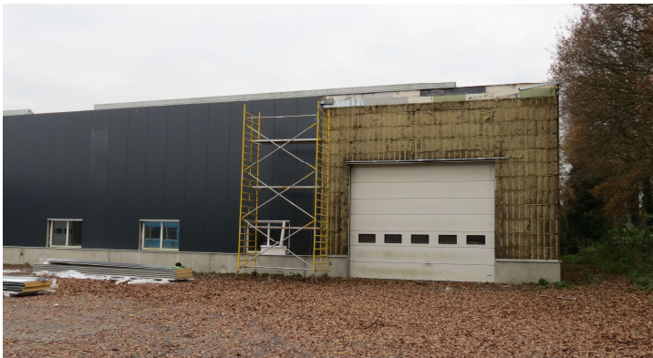
Bild 2.58: Montage der neuen Außenschale aus vertikal verlegten Sandwichelementen
