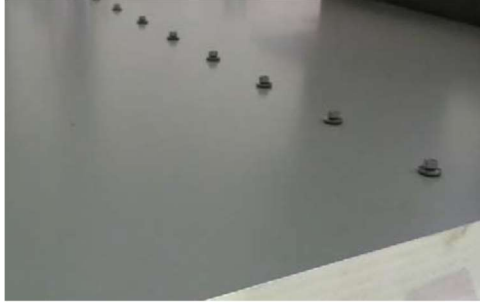
Bild 2.33: Sichtbare Schraubenköpfe bei Befestigung in Durchsteckmontage [59]
