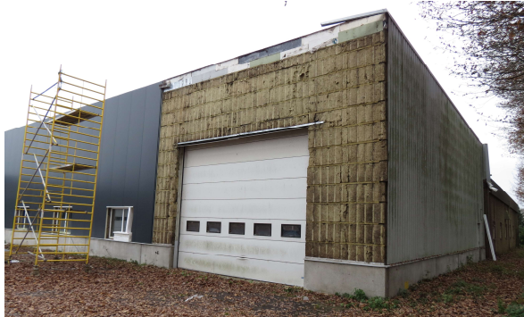
Bild 1.1: Energetische Sanierung einer Kassettenprofilfassade mit Sandwichelementen
