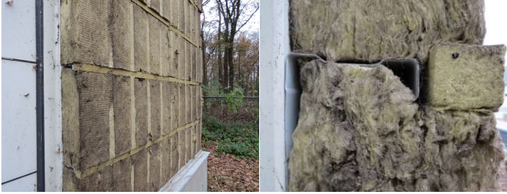
Bild 2.57: Bestandsfassade nach Demontage der Außenschale
