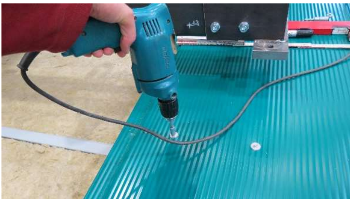
Bild B.5: Sichtbare Befestigung der Sandwichelemente in Durchsteckmontage (Längsabstand s_1 = 200 mm)
