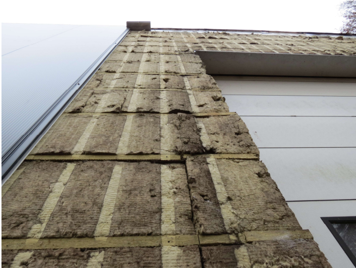
Bild 2.59: Detailansicht Montage der Sandwichelemente
