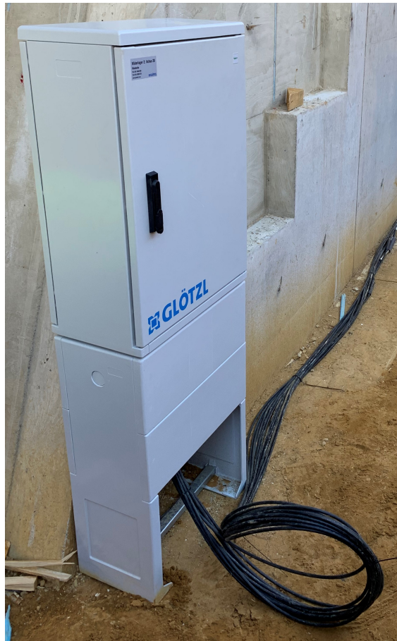
Abbildung 10.6: Gehsteigverteiler mit Datenloggern
