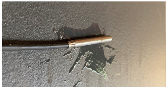
Abbildung 10.8: Aufgeklebter Temperatursensor auf einen Stahlträger
