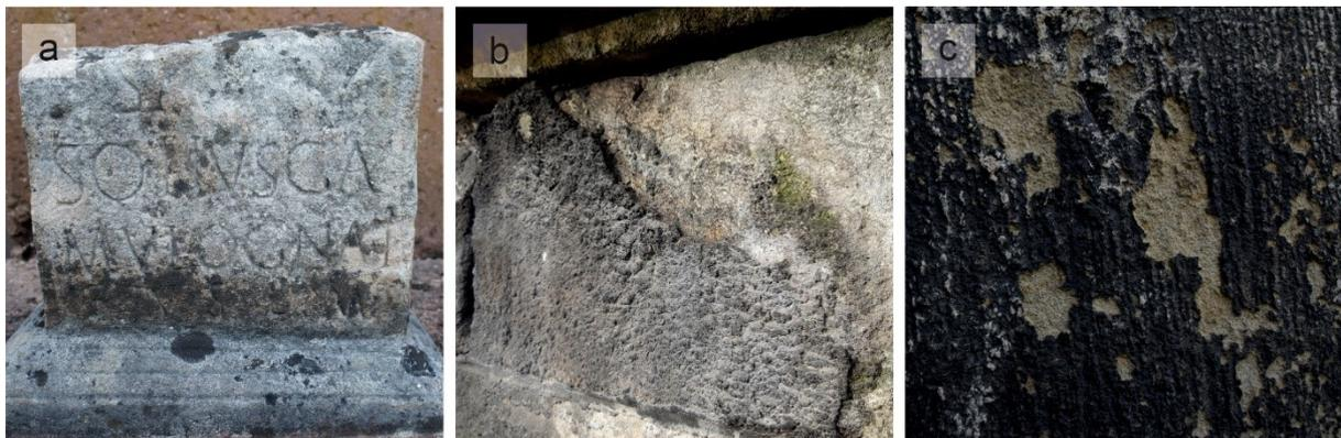
Abb. 2-10: (a) Verdunkelung der Natursteinoberfläche, (b, c) dichte und flächig aufsitzende Gipskrusten auf silikatischen (b) und karbonatischen (c) Oberflächen.
