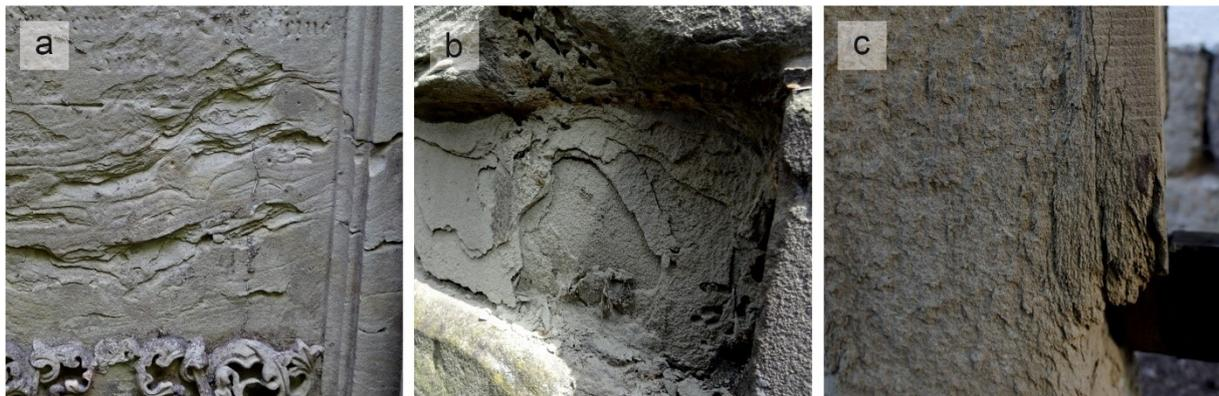
Abb. 2-7: (a) Schalenbildung der Gesteinsschichtung folgend, (b) Schalenbildung mit tiefreichender Rückverwitterung, (c) schalenartige und oberflächenparallele Rückverwitterung sowie Materialverlust.
