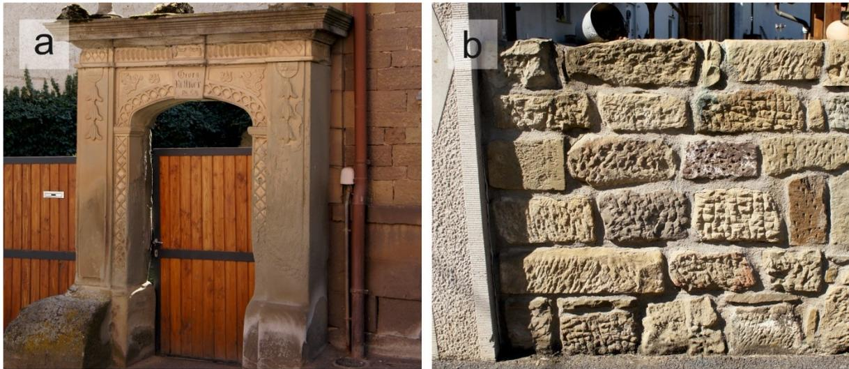
Abb. 3-11: Verwendung des Schleieriether Sandsteins am Bauwerk, für die Gestaltung eines Eingangsbereiches (a), sowie die Nutzung als Baustein für Mauerwerk mit unterschiedlicher Oberflächenbearbeitung (b), Schleierieth.
