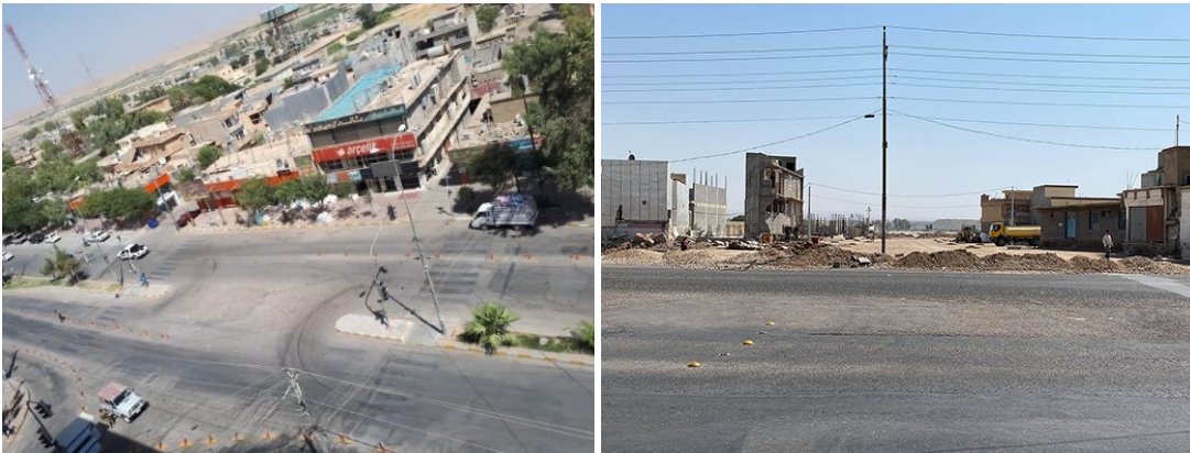
Abb. 11: Erweiterung der Straße: Links vor dem Abriss, rechts nach dem Abriss 111
