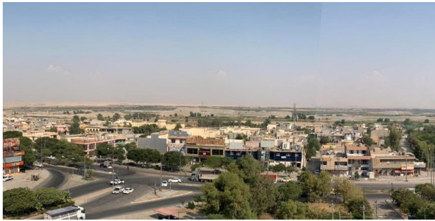
Abb. 13: Blick auf Stadtteil Scherwana 113
