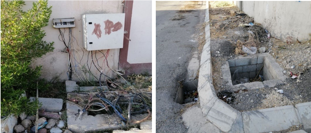
Abb. 87: Installation Stromanschluss (links) und Gehweg und Kanalisation (rechts) 257
