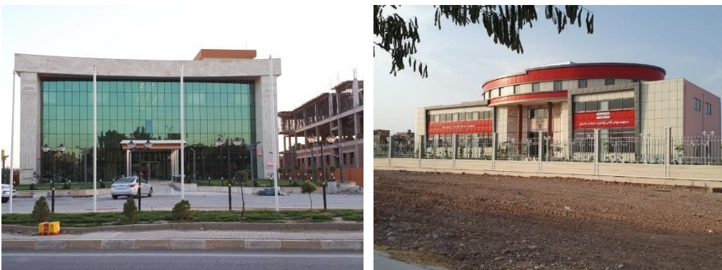
Abb. 69: Privates Krankenhaus (links) und öffentliches Gebäude (rechts) 211
