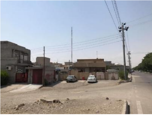
Abb. 33: Vom Abriss bedrohtes Haus 161
