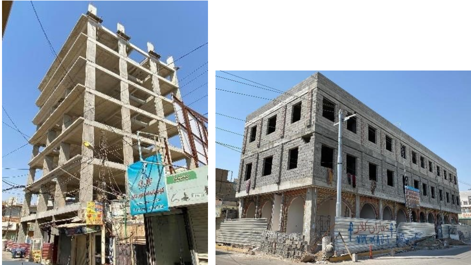
Abb. 70: Neue Geschäftshäuser aus Skelettbau in der Innenstadt 212
