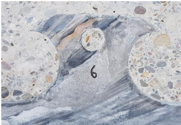
Abbildung 7-20: Aufhängepunkt des Trägers mit Beton gefüllt, nach Sägeschnitt
