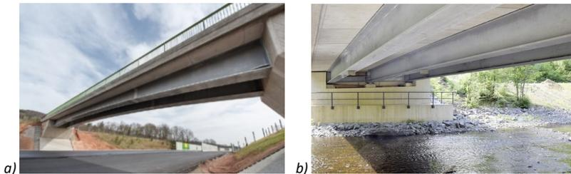
Abbildung 1-2: a) Pilotprojekt, feuerverzinkte Verbundbrücke an der A44 [24]; b) Feuerverzinkte Rurbrücke Grünental in Monschau [60]
