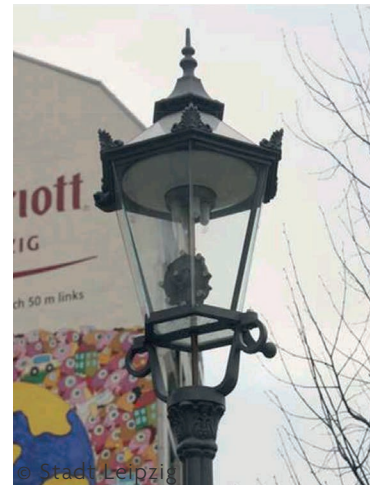
Abb. 14: Auf LED umgerüstete Schinkelleuchte in Leipzig (Stadt Leipzig 2019b: 36)
