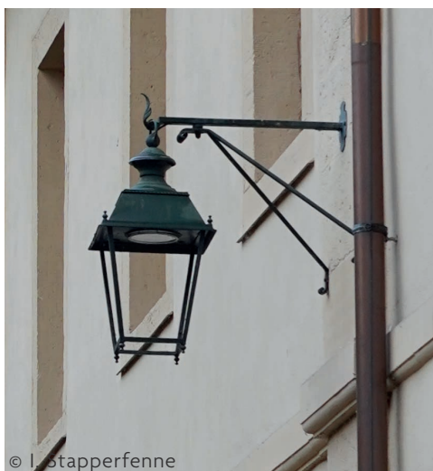
Abb. 10: Auf LED umgerüstet Laterne in Fulda (I. Stapperfenne 2020)
