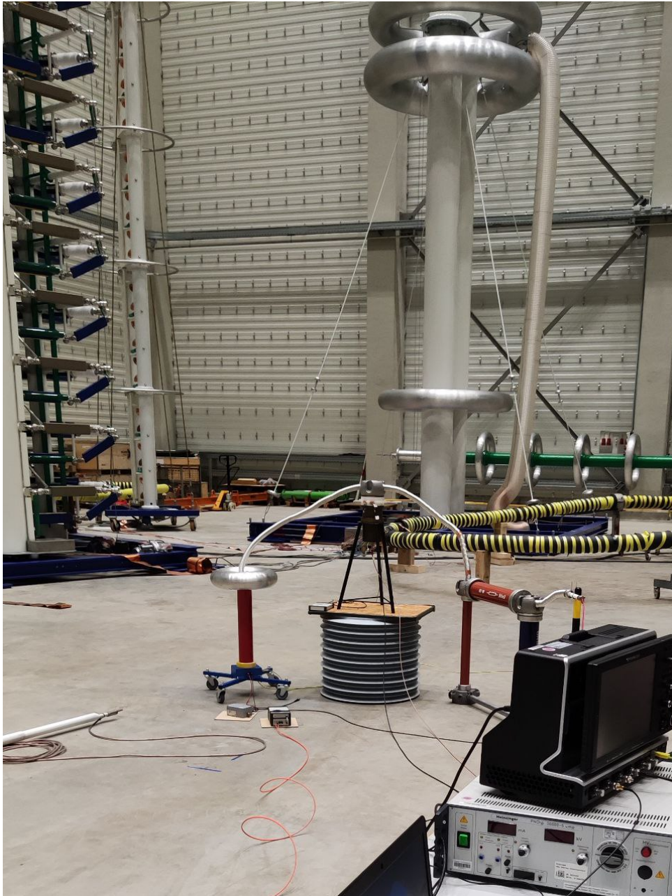
Abbildung B.9: Messaufbau in der Hochspannungshalle
